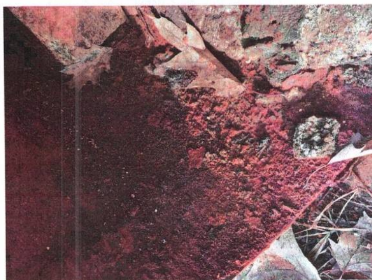
Fot. 12,13. Pęknięcia rurociagu.
