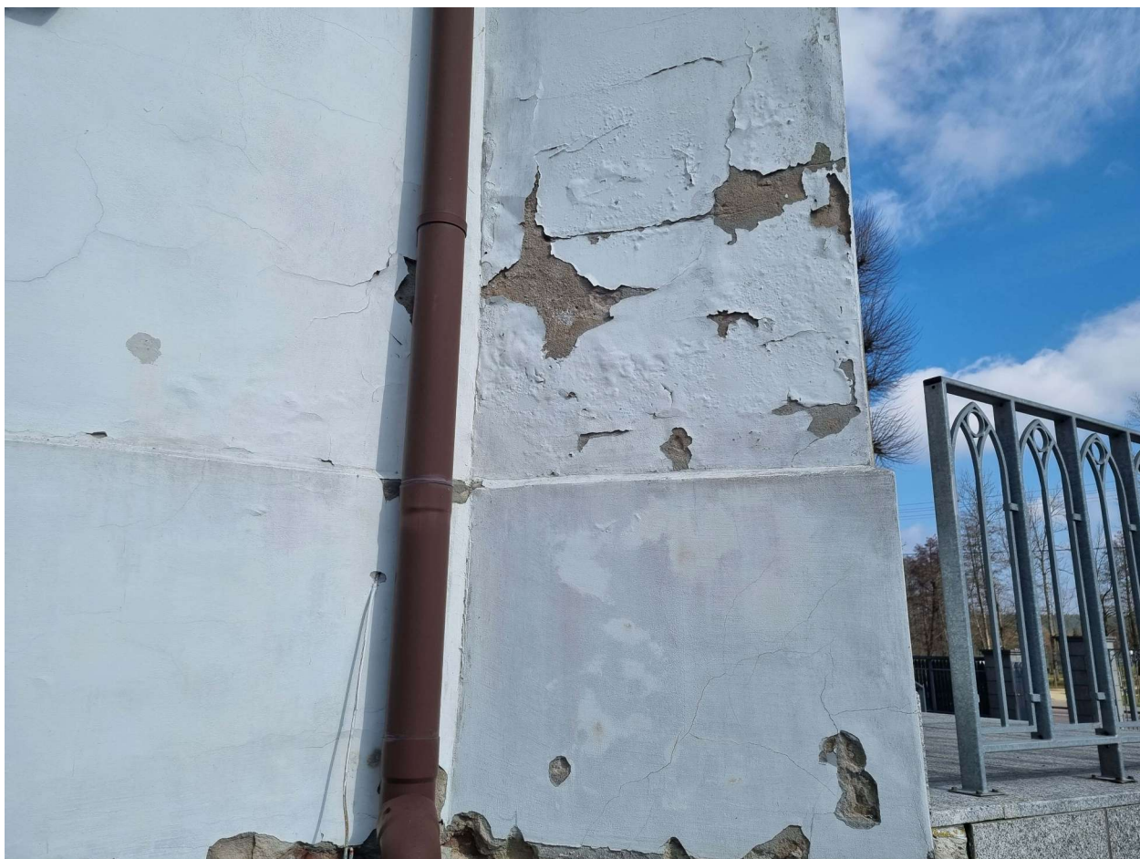
Cokół spękania tynku.
